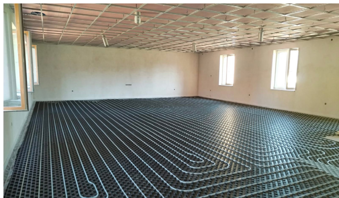
V budově je funkční krb, položené podlahové topení a jsou zabetonované podlahy.
